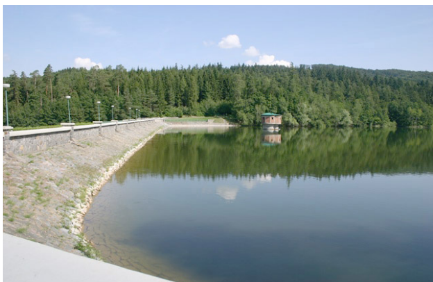
zásobovací služby zdroj pitné vody vodní nádrž Koryčany
